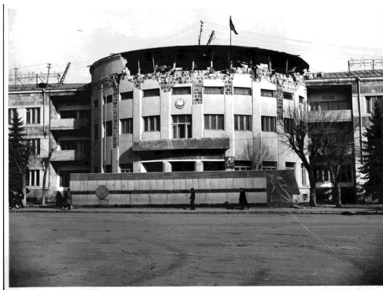
Рис. 8б. Здание ленинканского горсовета после землетрясения, 1988 г.
